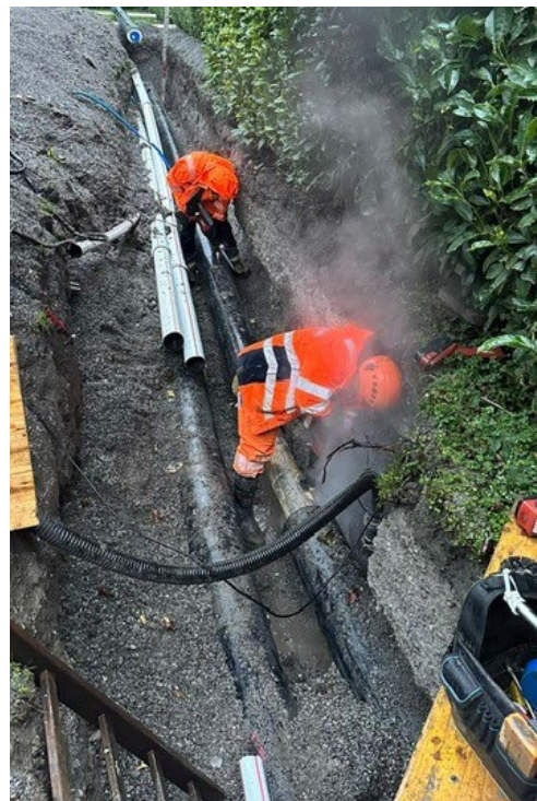
Austausch Fernwärmeleitung
