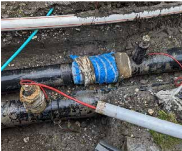
Reparatur Kugelhahn Rheinstrasse
