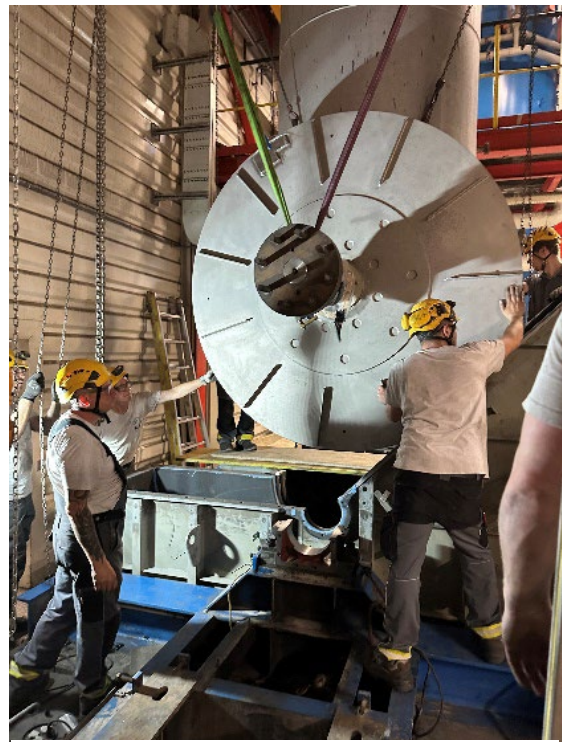
Revidiertes Laufrad
