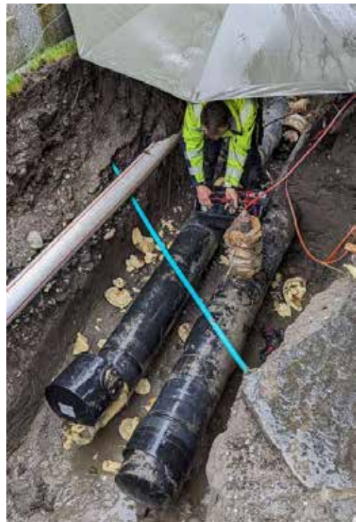
Reparatur Kugelhahn Rheinstrasse
