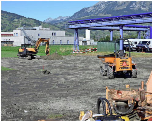
So zeigte sich die Baustelle am Dienstag.
